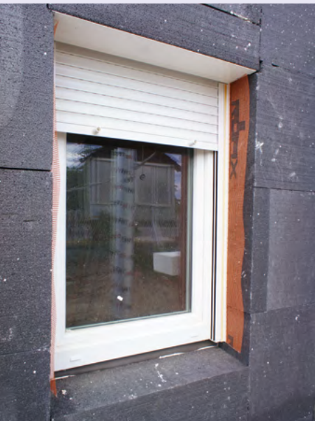
Richtig: Fensterrahmen überdämmt und abgeschrägte Dämmung bei Fensterbrett.
