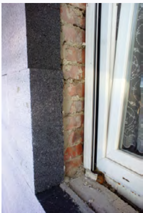
Bei diesen Fenstern ist eine Leibungsdämmung nicht mehr möglich.
