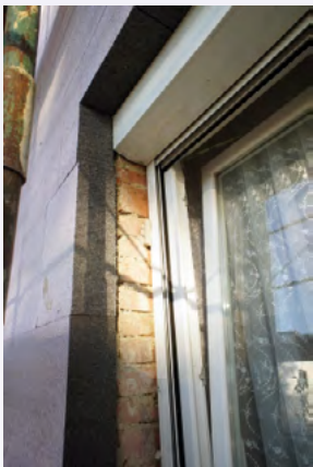
Bei diesen Fenstern ist eine Leibungsdämmung nicht mehr möglich.
