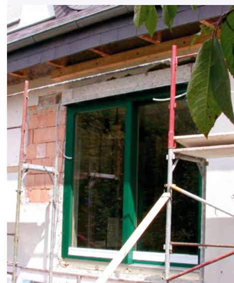
Verbesserung der Belichtung durch Einbau größerer Fenster.
