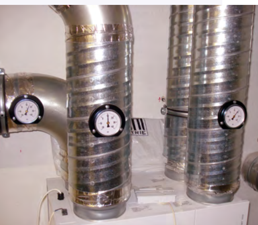
Zentrales Lüftungsgerät
