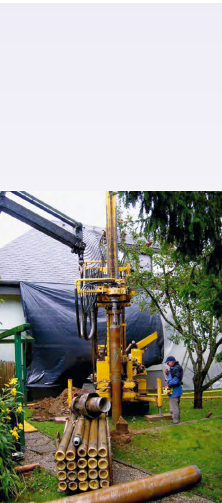
Tiefenbohrung für Erdreich-Wärmepumpe
