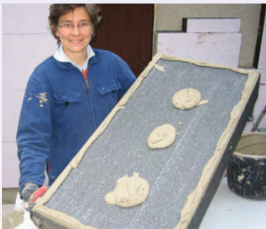
Der Kleber wird immer mit der Randwulst-Punkt-Methode aufgebracht.
