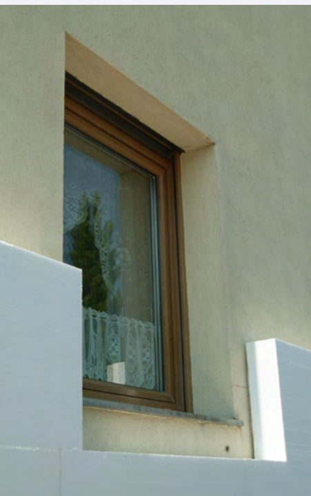
Der Lichteinfall durch dieses Fenster wird durch die Dämmung reduziert, wenn nicht die Leibungsdämmung abgeschrägt wird. Es bleibt seitlich auch nicht viel Platz zum Überdämmen des Fensterrahmens.
