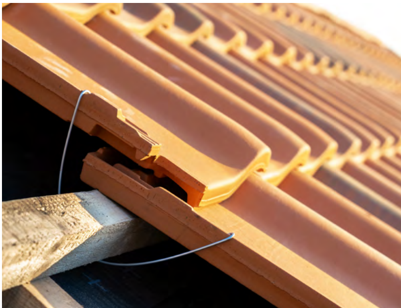
Sturmklammern fixieren Ziegeln und Dachplatten. | © Bilanol/Shutterstock.com
