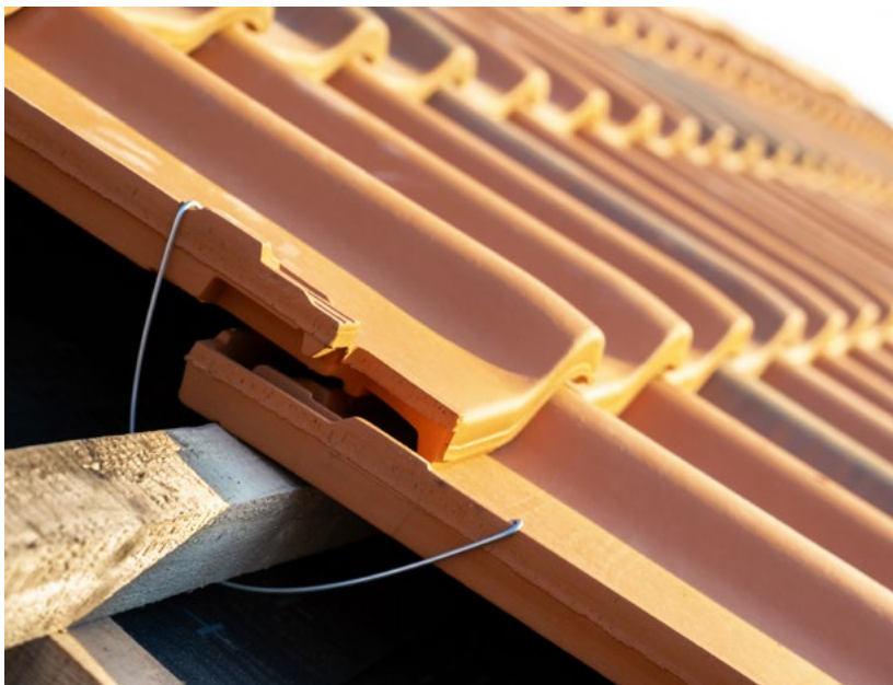
Sturmklammern fixieren Ziegeln und Dachplatten. | © Bilanol/Shutterstock.com
